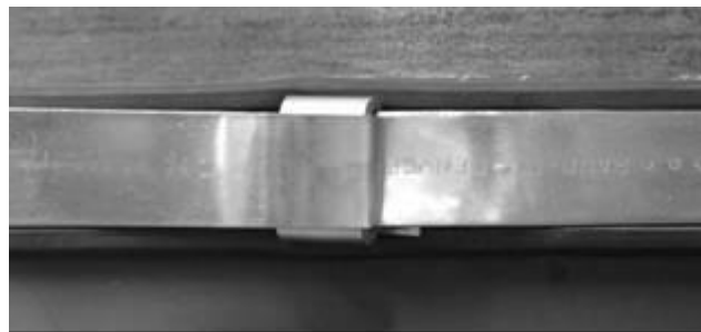
Figur 2-20: Bandklämmans slutliga installation
