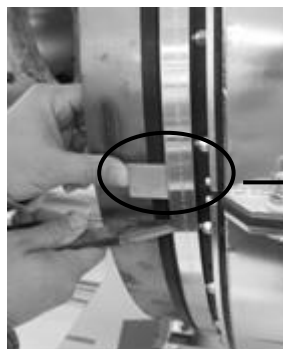
Figur 2-24: Installering av splittskyddsplatta
