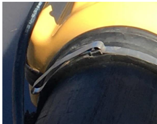
Figur 2-21: Bandklämmans slutliga alternativa installation
