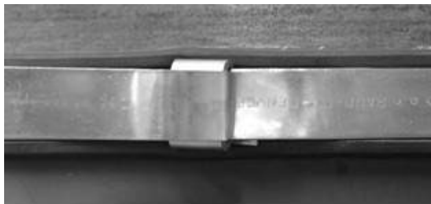
Рис. 2-20: Окончательная установка стяжного хомута
