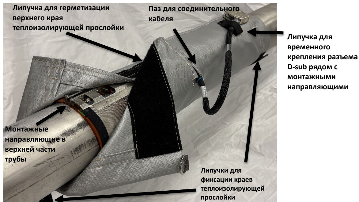
Рис. 2-12: Установка теплоизолирующей прослойки поверх ХОМУТА для труб диаметром менее 6 дюймов и двух ХОМУТОВ
