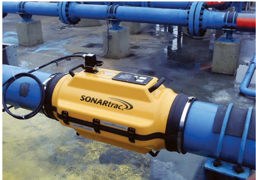
La instalación de los flujómetros de sonar pasivos se instalan siempre en el exterior y nunca entran en contacto con los líquidos.
