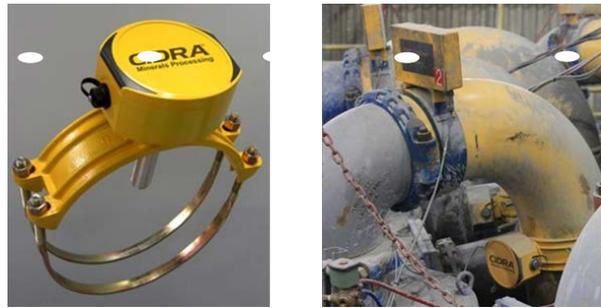
Figura 11 Izquierda, sensor del CYCLONetrac PST. Derecha, sensor del CYCLONetrac PST instalado en la tubería
