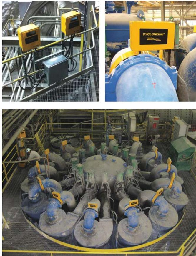
Figura 5 Sistema CYCLONetrac OSM instalado con transmisor y caja de conexiones (foto superior izquierda), cabezal del sensor (foto superior derecha) y una batería de hidrociclones completamente instrumentada (foto inferior)
