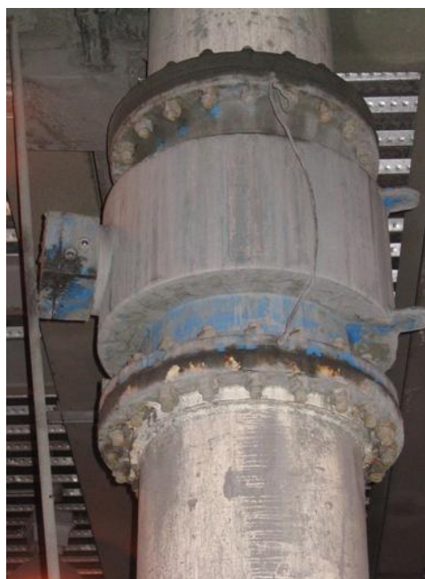
Рис. 2: Магнитный расходомер
