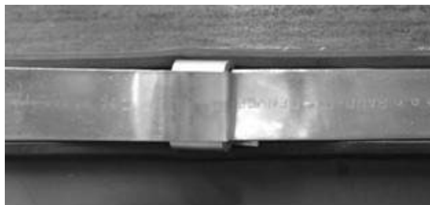
Figur 28 Bandklämmans slutliga installering
