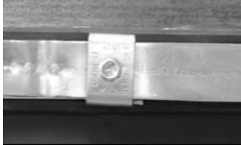
Figur 24 Gummidamask lindad runt gummidamask i skåra
