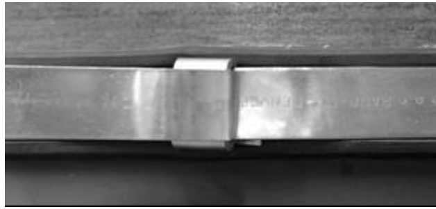
Рисунок 28 Окончательная установка стяжного хомута
