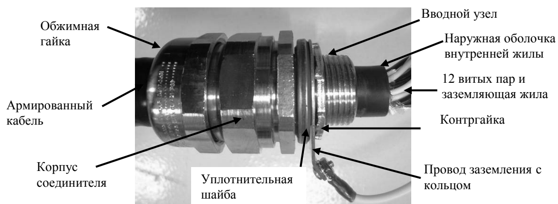
Рисунок 13 Установленный разъем армированного кабеля
